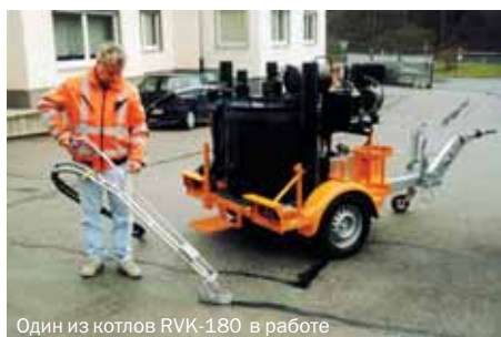
Один из котлов RVK-180 в работе
