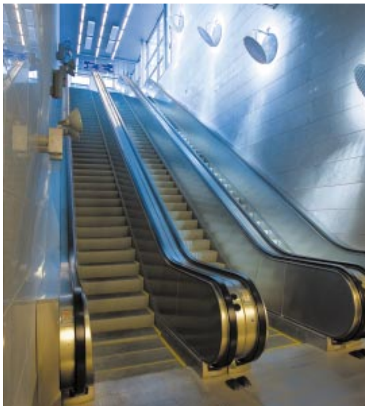
Рис.3. Тоннель эскалатора СК
