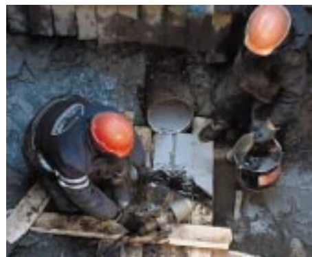
Фото 6-7. Выполнение работ и вид внутренней поверхности при санации водовода по методу "Pipe Way" в Приморском районе Санкт - Петербурга
