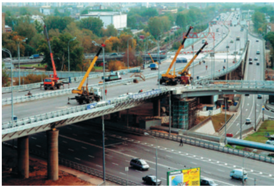
Сооружение эстакады в районе Нижегородской улицы
