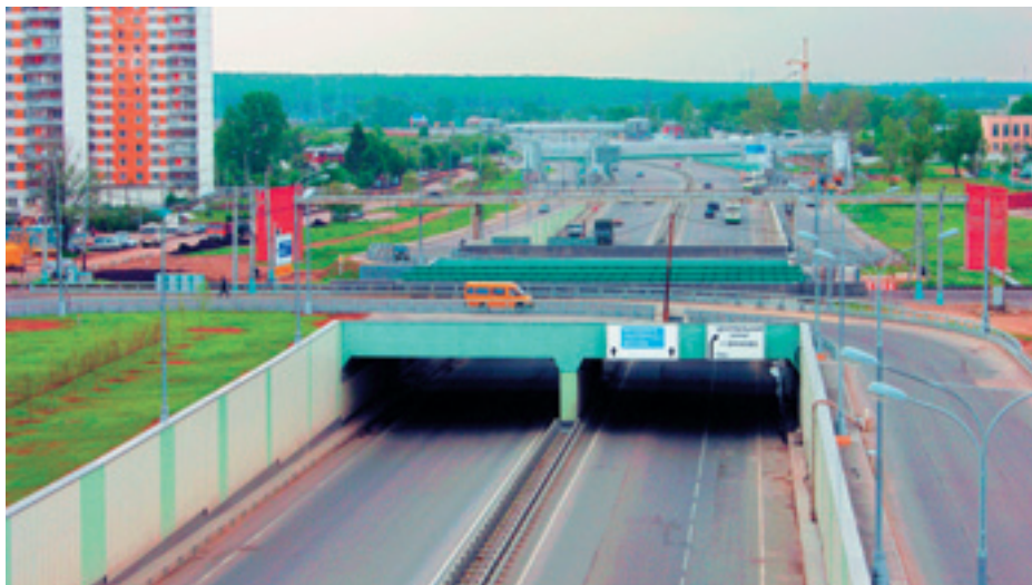
Путепровод для пропуска автомобильного и железнодорожного движения над Боровским шоссе
