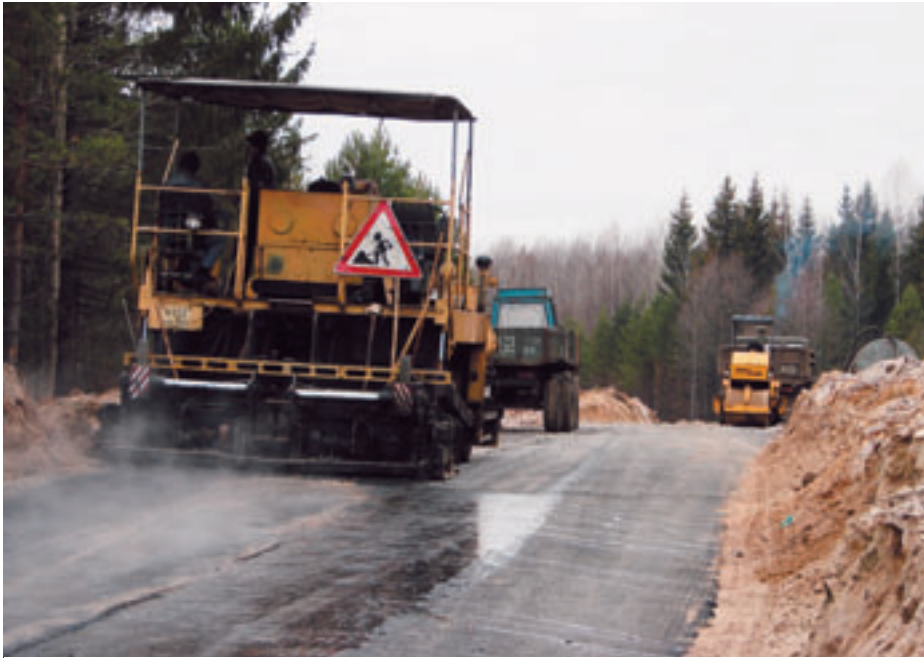
Строительство дороги к поселку Люля
