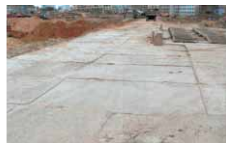
Рис. 5 Опытные участки временной дороги с покрытием из железобетонных плит 2П30.18-30В
