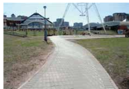
Рис. 3 Благоустройство территории «Золотых ключей» с использованием криволинейных бортовых камней.
